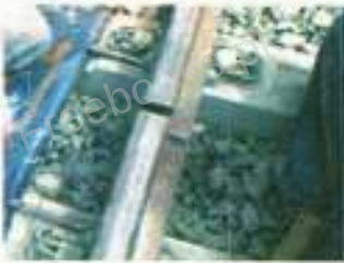
شکل 8.15: موسم گرما کے دوران حرارتی پھیلاؤ کی خلاف ورزی کے لیے ریلوے کی ٹریکوں میں خالی جگہ چھوڑی جاتی ہے۔
